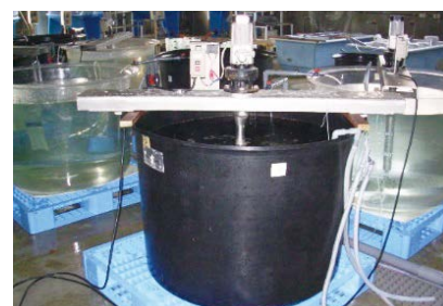
写真1. 攪拌機を設置した水槽の様子
