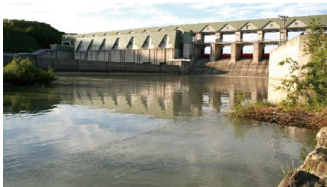
▲写真-1 二風谷ダム
