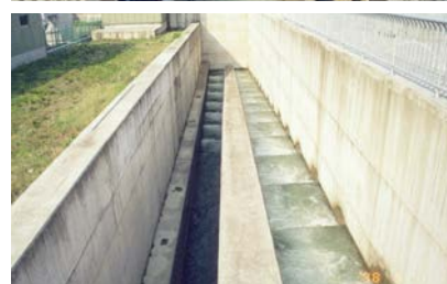
▲写真-2 二風谷ダム魚道 （上:可動部、下:固定部）
