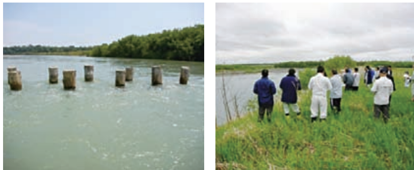
写真左：沙流川下流部に設置されたシシャモ産卵床保全を目的とした水制工 写真右：シシャモ産卵床保全に関する漁業関係者と河川管理者の意見交換会
