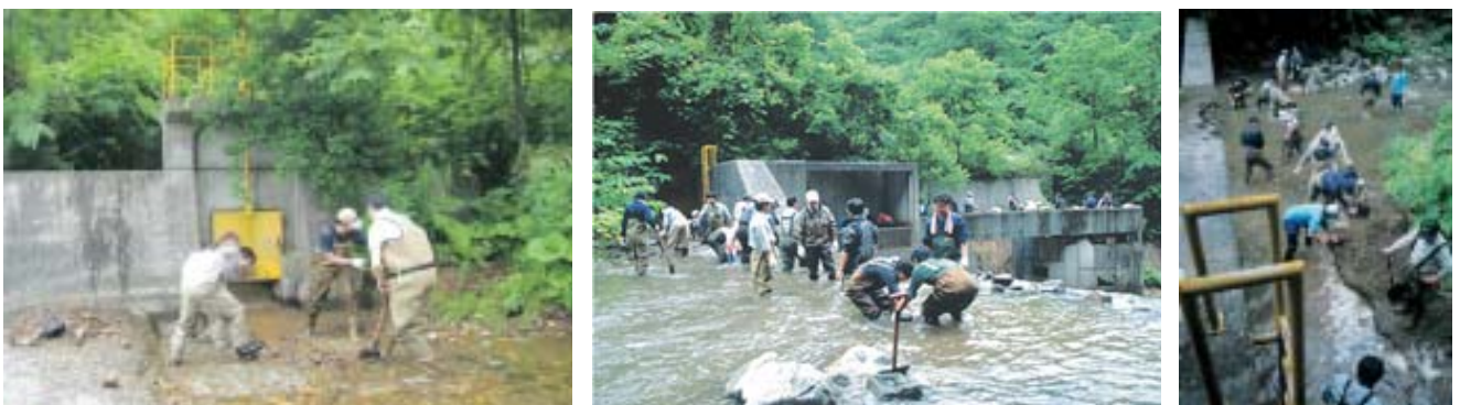
写真5 魚道清掃作業の様子（左：後志支庁水産課、中央および右：檜山漁業士会、せたな町の釣り愛好会「一平会」、檜山支庁他の皆さんによる作業）。このような地道な作業が毎年、サクラマスの遡上期の前に行われている。
