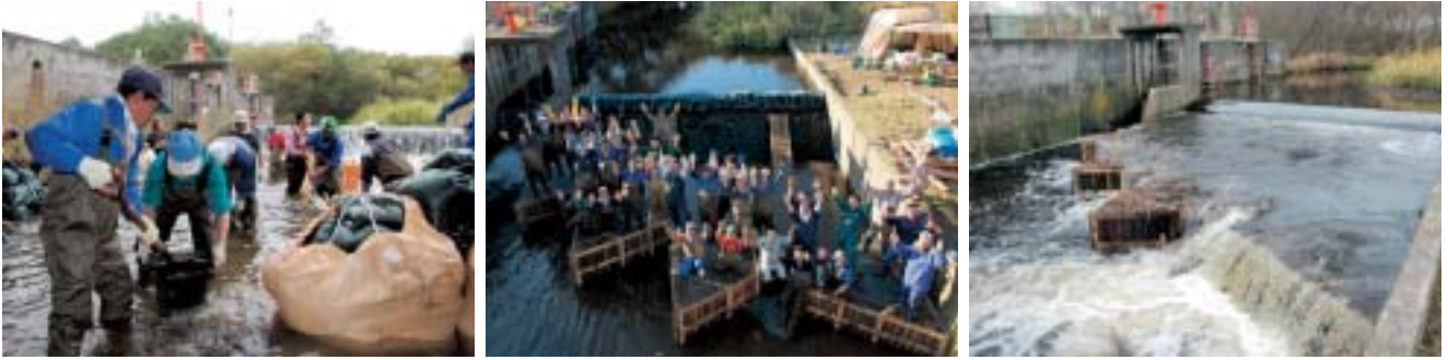
写真6 浜中町の酪農家など住民グループが中心となって作った手作り魚道（風蓮川支流三郎川）
