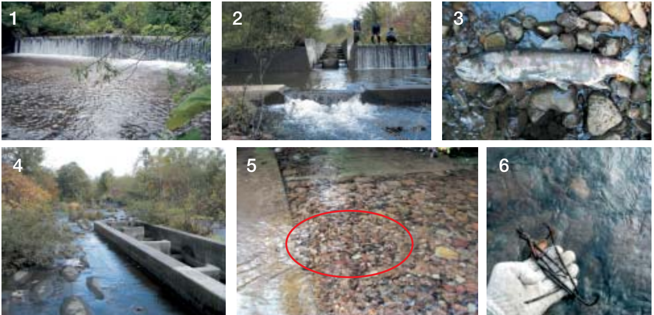
写真4 尻別川支流オサンナイ川の様子（1：連続して造られた落差工。2：落差工に造られた魚道。3：魚道設置区間に遡上したサクラマスホッチャレ。4：コンクリートブロックで固められた河床。5：わずかな砂利を集めて造られたサクラマスの産卵床（赤丸の部分）。6：産卵床の中から出てきた建設用資材。
