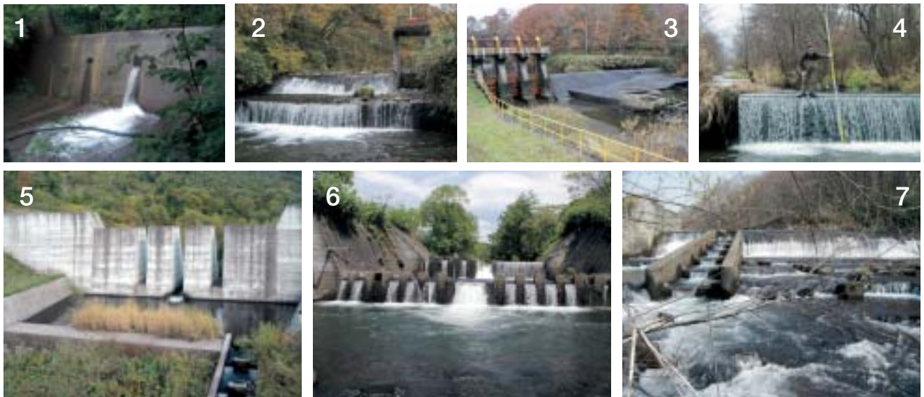
写真2 尻別川に建設された様々なタイプの河川横断構造物（1～7）と魚道（5～7）。写真4はサクラマスの遡上条件を調べるため堰堤の落差と水深を調べている様子（平成19年）。
