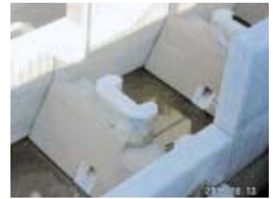
写真4 川向頭首工魚道の底生魚の遡上に配慮した隔壁
