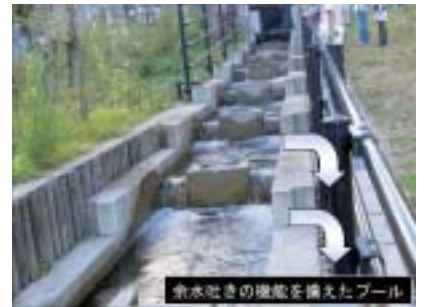
写真1 開撫床固工ハイブリット魚道 せた魚道。
