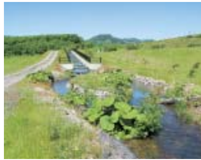
写真3 美利河ダム魚道
