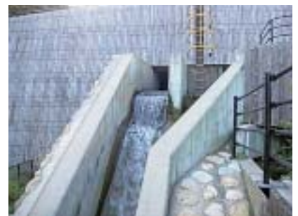
写真2 上坂本砂防堰堤の魚道 上：ラセン式魚道 中：余水吐きを備えたプール 下：呼び水を兼ねた余水吐き 田川に設置された上坂本砂防堰堤に設置されたアイスハーバー型の魚道です。この魚道は、砂防ダムの下流に流入している支流との交差を避けるため、設置面積が小さいラセン式を採用しています。ラセン式魚道は、プールの内側と外側で流速の差が生じ流況が不安定になってしまう欠点がありますが、この魚道は余水吐きを設けることにより流量を一定に保ちプール内流況を安定させています。また、余水吐きの水を魚道入り口の近傍に流すことによる、呼び水の効果も期待されます。
