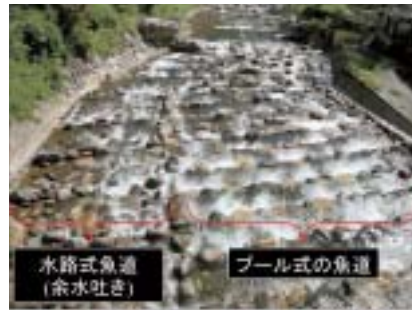
写真1 開撫床固工ハイブリット魚道 せた魚道。
