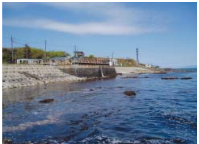
図12 寿都町六条におけるヒラメ種苗生産施設の排水口
