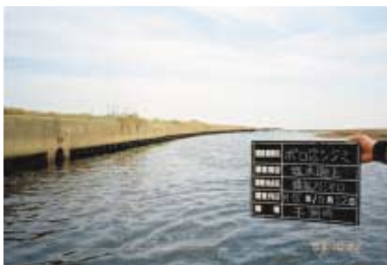
写真1 猿払川河口（左岸：導流堤）
