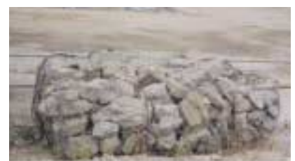
写真4 設置に使われた石カゴ
