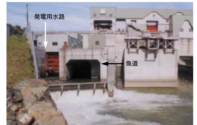
写真2 発電用水路と魚道
