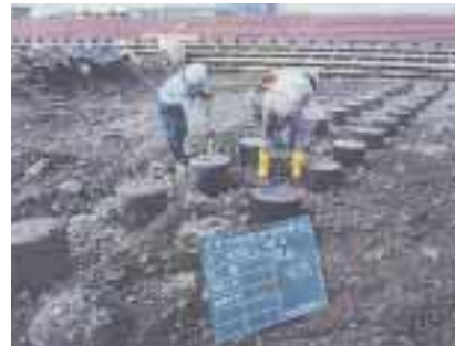
写真2 平成6年度施工の水制工
