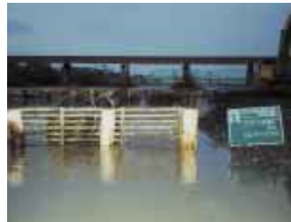
写真1 平成4年度施工の水制工
