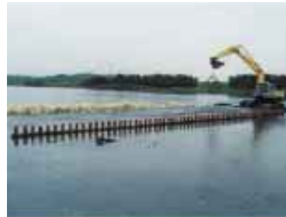
写真3 平成9年度施工の水制工
