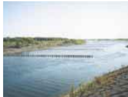
写真4 平成11年度施工の水制工
