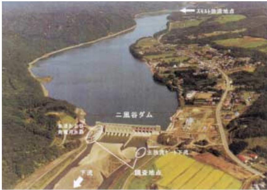
写真2 調査地点(写真は二風谷ダム管理所資料より引用)
