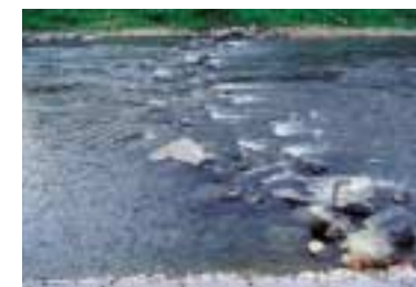
写真2 巨石の帯工、下流側に深みを形成
