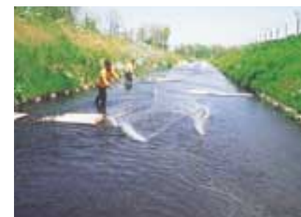
写真1 改修直後の改修区間
