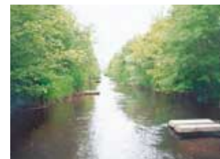
写真2 現在の改修区間
