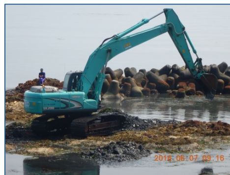
[水深がある溝などは、バックホーで清掃]
