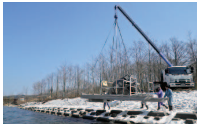
写真-6 スクリュートラップ設置状況
