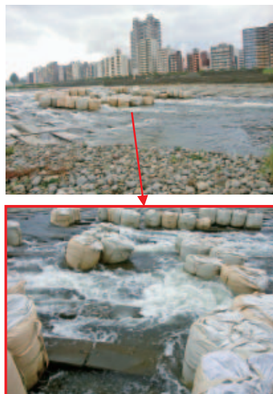
写真4 5号床止護床工に土嚢を設置した状況(平成20年10月)
