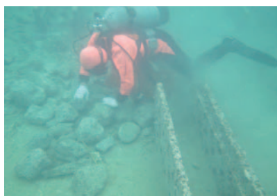
写真4 潜水調査状況
